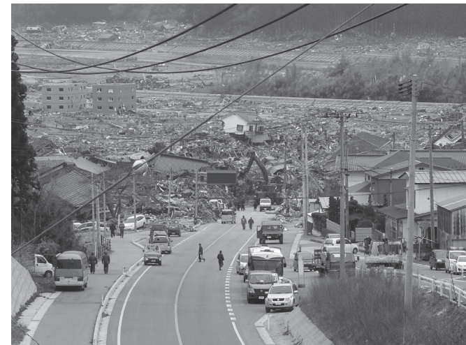
写真 道路啓開作業状況（陸前高田市）
