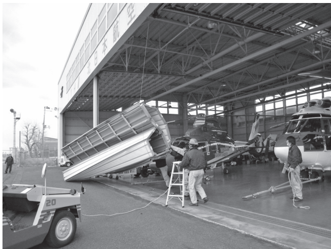
写真 地震で壊れた格納庫シャッターの撤去
