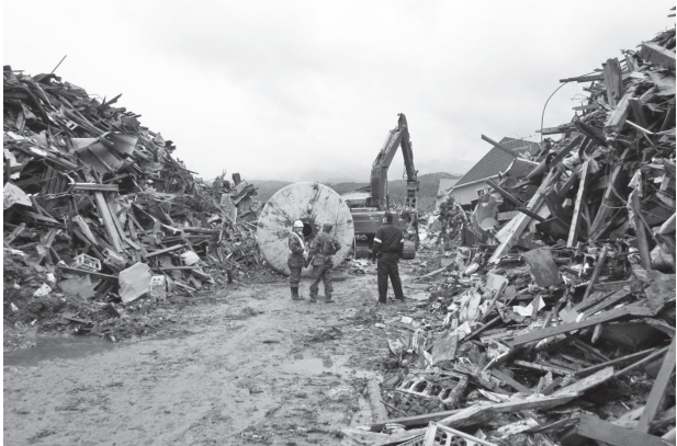
写真 道路啓開作業状況(国道45号陸前高田市)
