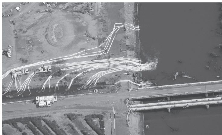
写真 緊急排水状況（3月24日）
