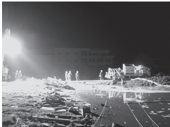
写真 排水作業状況（宮城県亘理町荒浜中学校付近）
