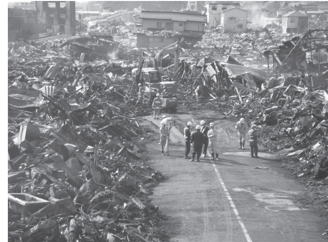
写真 道路啓開作業状況（気仙沼市）
