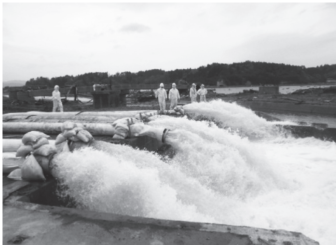
写真 排水作業状況（福島県南相馬市小高区）
