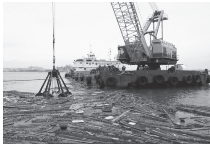
写真 航路啓開作業状況(石巻港 流木除去)
